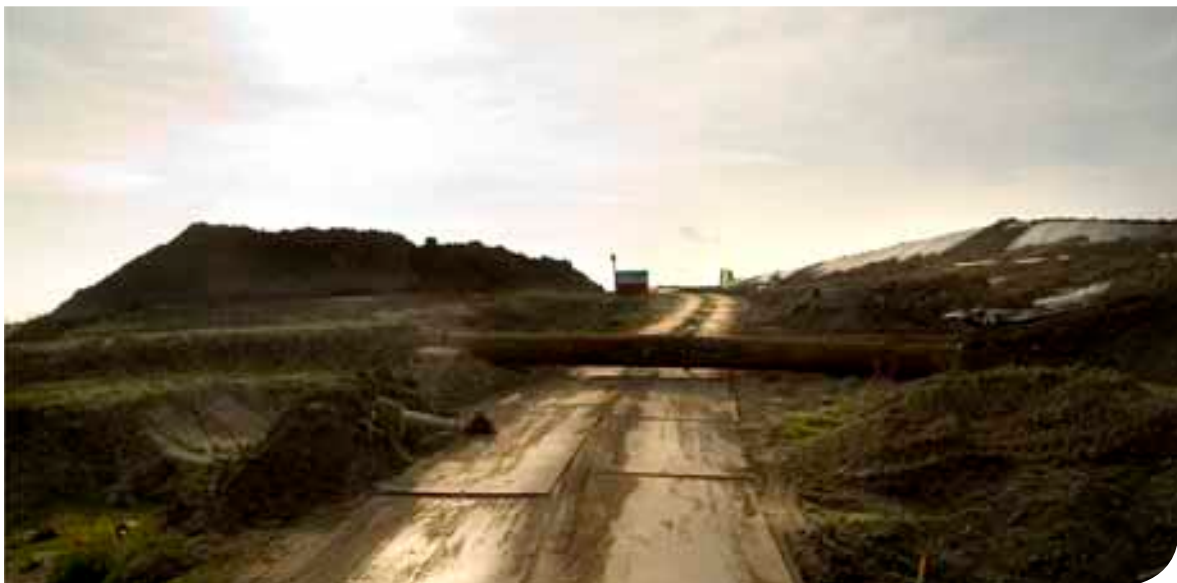
Werk in uitvoering
