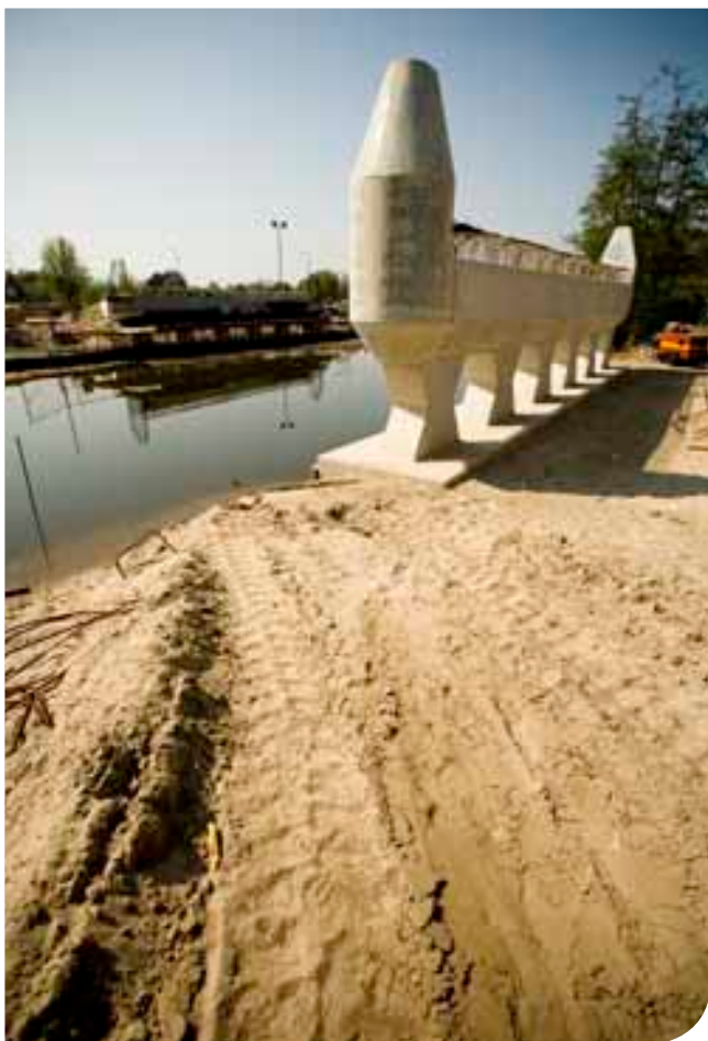
Aanleg van een brug, Woerden
